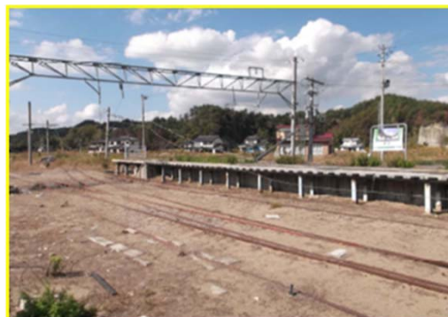
被災した野蒜駅
