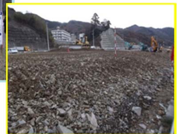
↓ 中心部かさ上げの状況
